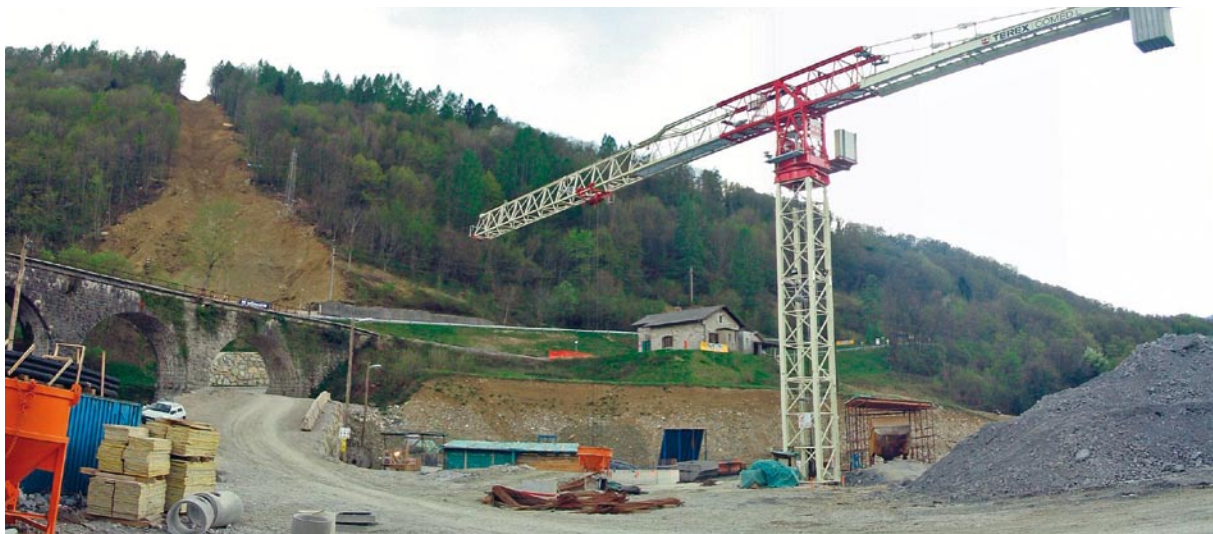
Bauplatz für die Schachtzentrale, im Hintergrund Erdarbeiten für die Druckleitung
