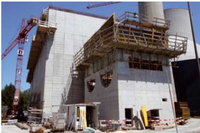
Nasslager und südlicher Kühlturm in Ausführung Wet Storage and Southern Cooling Tower under construction
