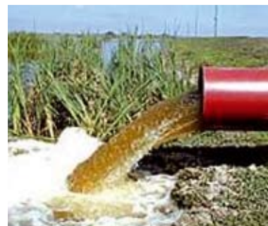
Beispiel eines Auslaufes mit unbehandeltem Abwasser
