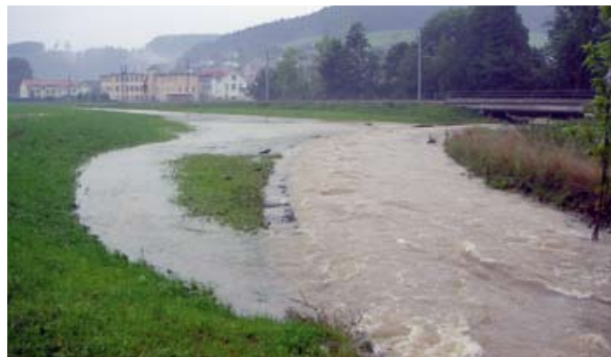
Entlastung der Suhre über einem Streichwehr in ein Überflutungsgerinne während dem Hochwasser 2005 Discharge of flood by a lateral weir during the flood in 2005
