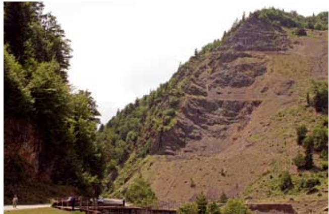
Rechtes Widerlager - Stand der Aushubarbeiten bis 1989 Right dam abutment - completed excavation work until 1989
