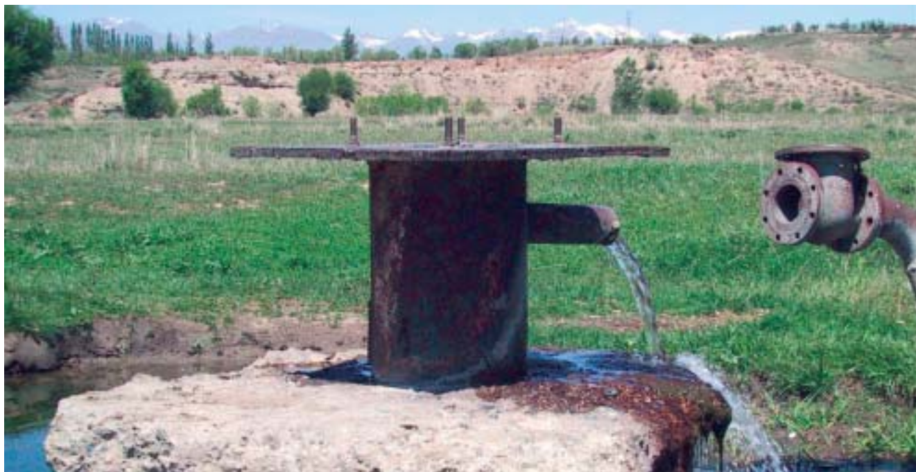
Unterbrochene Wasserleitung in Karakol
