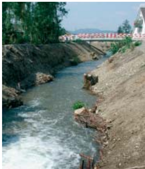
Ausgebauter, renaturierter Gewässerabschnitt kurz nach Fertigstellung Discharge improvement and re-naturalized river sector shortly after construction
