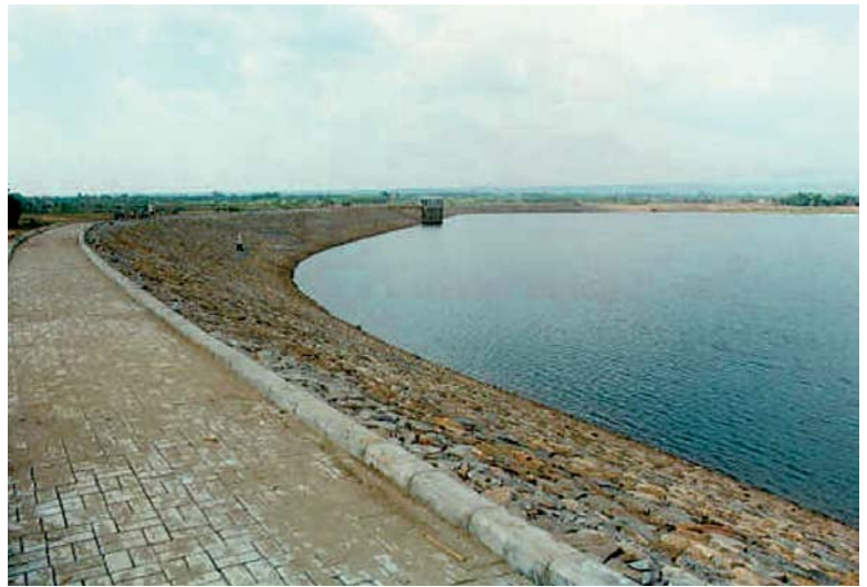
Bild 7: Der Lalung Damm nach der Sanierung Picture 7: Lalung Dam after rehabilitation
