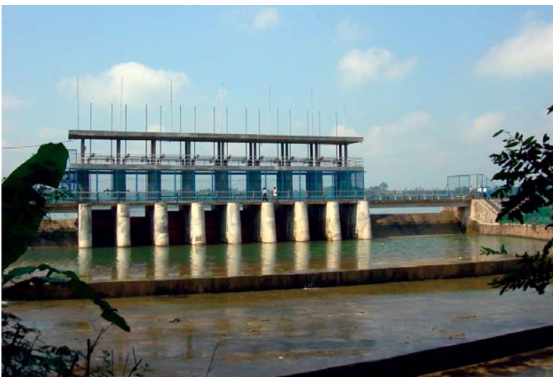
Bild 4: Delingan Hochwasserentlastung nach der Sanierung Picture 4: Delingan Spillway after rehabilitation
