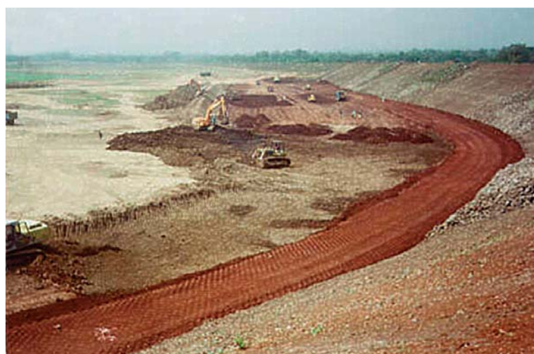
Bild 6: Der Lalung Damm während der Sanierung Picture 6: Lalung Dam during rehabilitation
