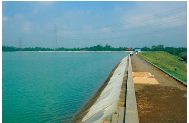
Bild 2: Der Delingan Damm nach der Sanierung Picture 2: Delingan Dam after rehabilitation
