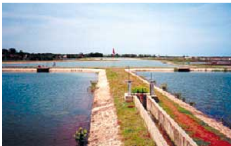
Urbanisierungsprojekt Cirebon - Siedlungsbereiche am Stadtrand Cirebon Urban Development Project - Settlement ponds on outskirts of the city
