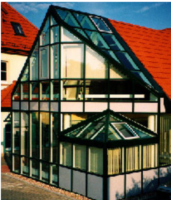
Das neue Kundenzentrum der Stadtwerke Meiningen/Deutschland The new info-centre of Stadtwerke Meiningen/Germany
