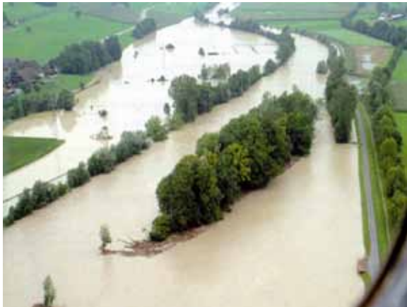
Schwemmhölzrückhalt im heute schon bestehenden Seitenarm Chamau beim Hochwasser vom August 2005 (links und rechts)
