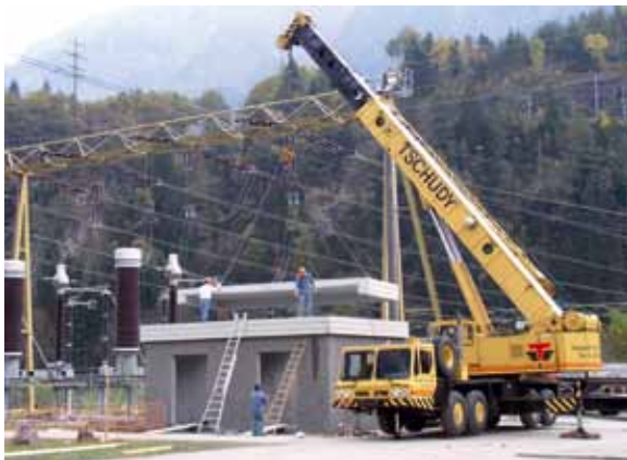
Installation Relaishaus (links) Temporäre Zufahrt, Montage Ü-Ableiter (rechts)
