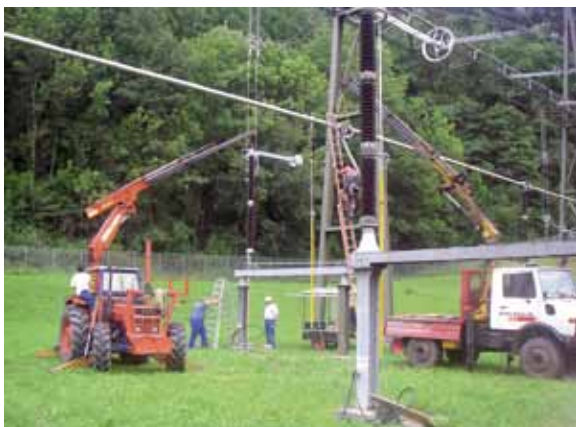
Demontage der alten SS-Trenner (links) Montage der neuen SS-Trenner (rechts)
