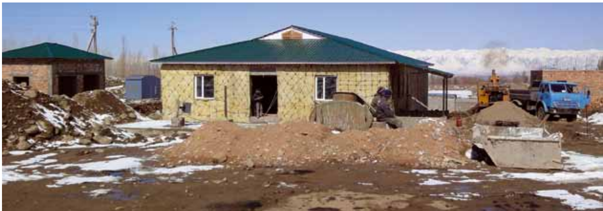
Gebäude der Wasseraufbereitungsanlage, März 2010
