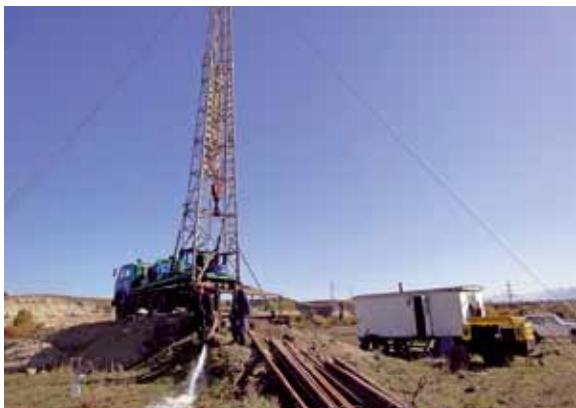
Sanierung von Grundwasserbrunnen (links) Neues Trinkwasserreservoir (2 x 1'500 m 3 ) (rechts)
