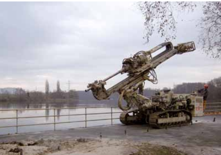
Bohrmaschine, Manschettenrohre (links), Bohrarbeiten (rechts)
