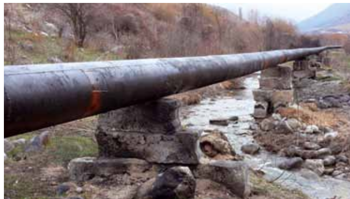
Freiliegende Wasserleitung
