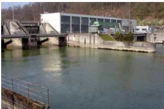
Das Flusskraftwerk Flumenthal (links) Schäden an der Zahnschwelle (rechts)
