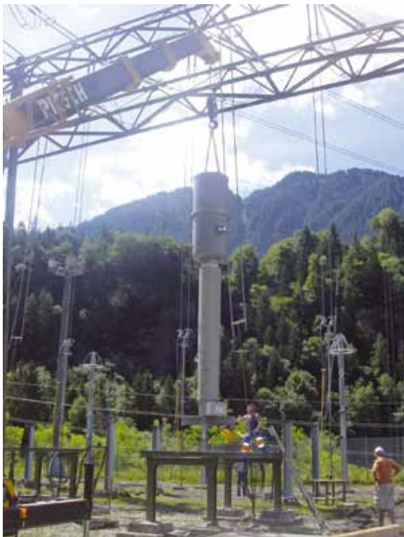
Montage der neuen SF6-Kombiwandler (links) Korrosionsschutz der Gerüste (rechts)
